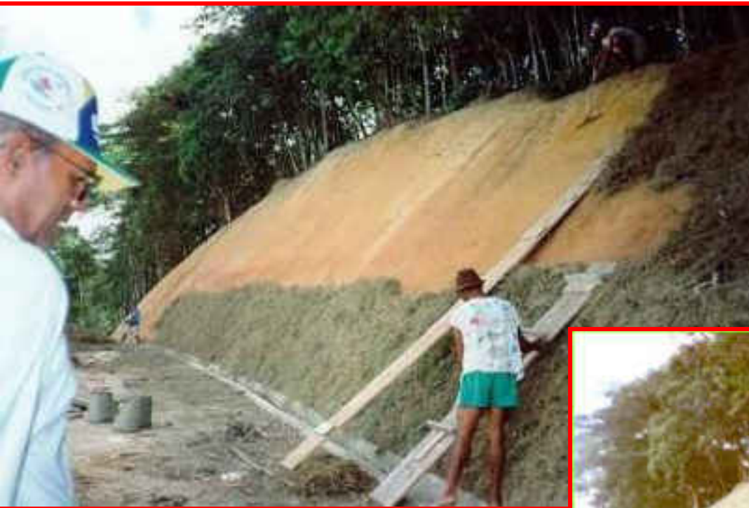
Implantação da Cobertura Vegetal
