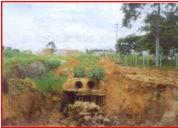
Galeria sem dissipador de energia.
