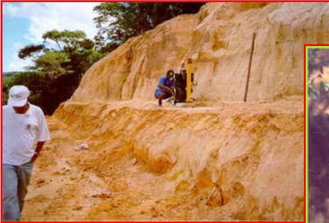
Compactação com o “SAPO”.
