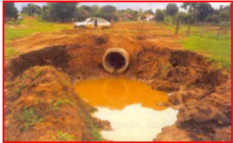
Lançamento do sistema de drenagem sem execução de dissipador de energia
