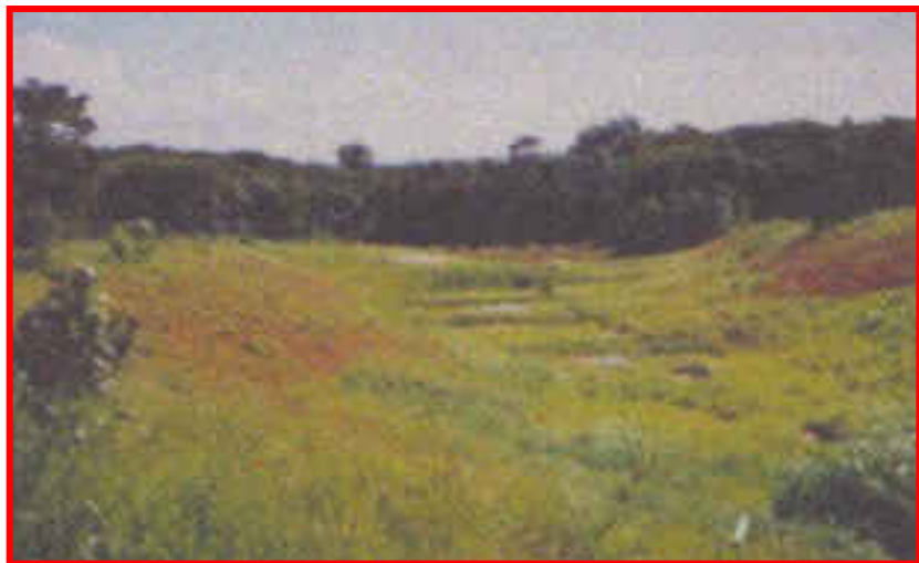
Retaludamento; drenagem e revegetação
